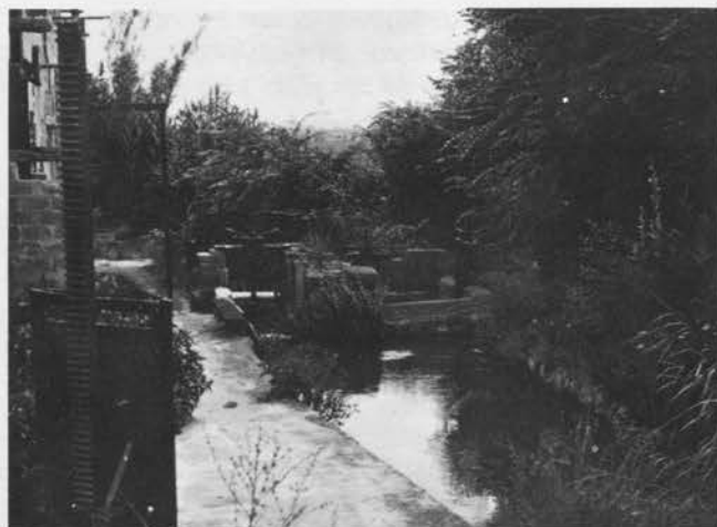
Acequia de entrada a la Central Eléctrica Larruga y Erviti (km 19,900)
